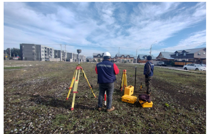
TOPOGRAFÍA CESFAM COLÓN CURICO, REGIÓN DEL MAULE
